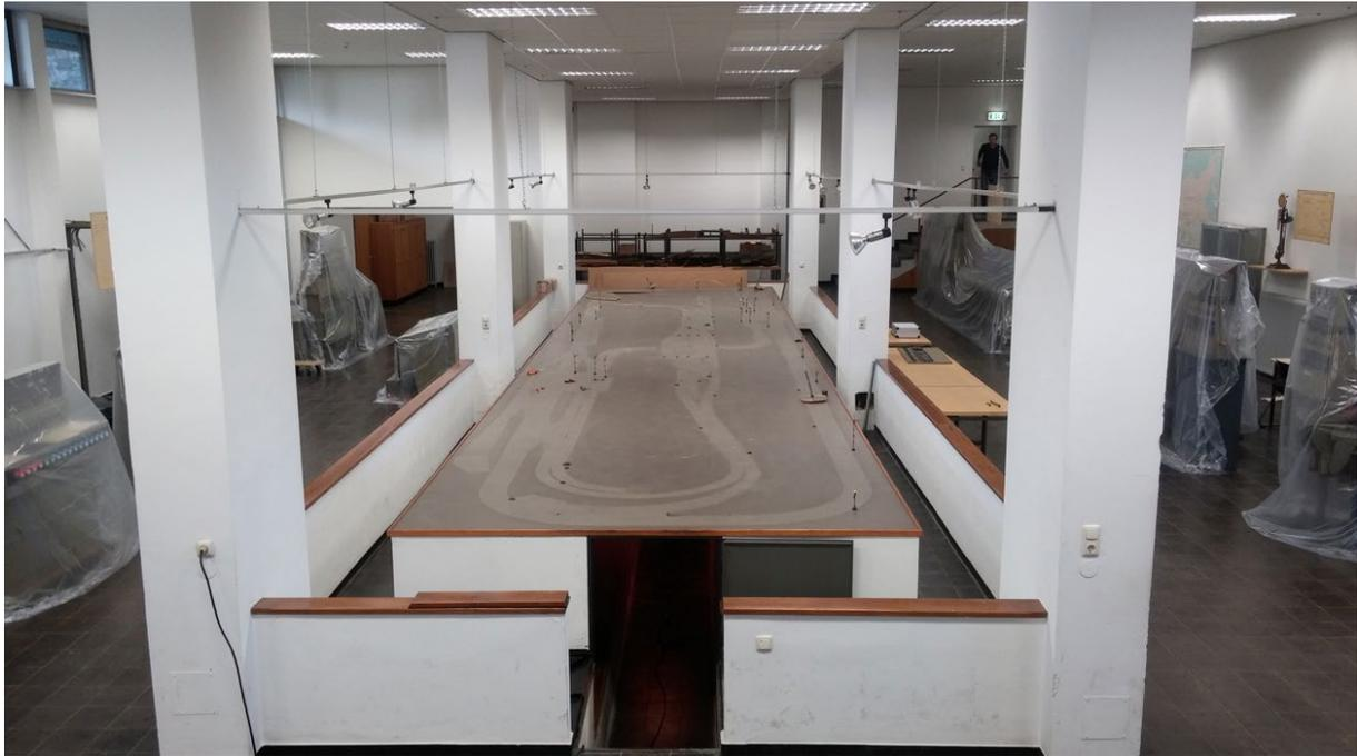
Die Spuren der Gleise heben sich nach gut 50 Jahren gut auf der Holzplatte hervor. Diese Holzplatte lagerte auf Doppel-T-Trägern, die wiederum auf den stahlbewehrten Seitenwänden verankert waren. Sowohl diese Wände als auch die Trennwände sollten nun in den kommenden Tagen (Wochen) herausgetrennt und entsorgt werden. Die Stellwerke, die auch nach dem Umbau noch an ihrer bisherigen Position erhalten bleiben, sind mit Abdeckfolie eingepackt, so dass diese den Umbau möglichst unverseht überleben.
